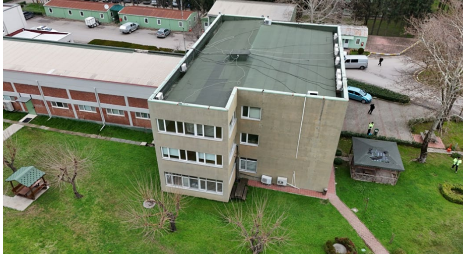
Şekil 6: MAM İdari Ek Binası
